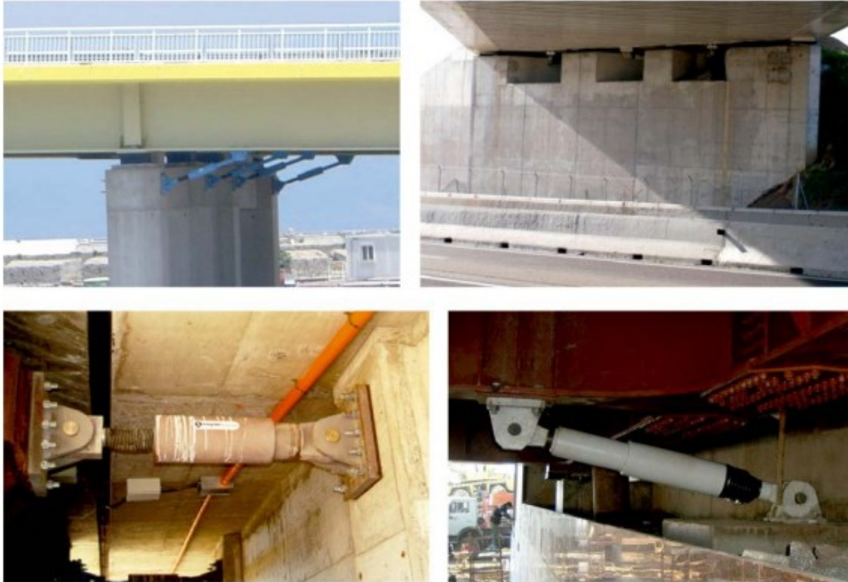
Figura 39 Ejemplos de amortiguadores viscosos dispuestos en puentes tanto en dirección longitudinal como transversal
