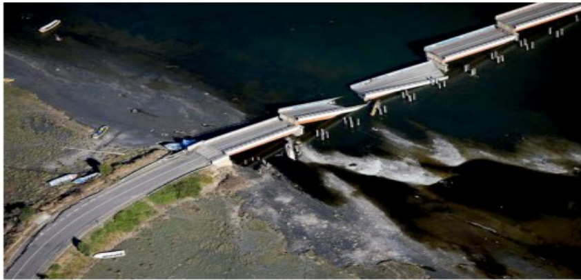
Figura 2 Colapso de varios tramos del tablero por pérdida de apoyo (Puente sobre el Río Tubul, Chile, terremoto de Concepción -27 de febrero de 2010-. Fotografía de Nicolás Piwonka, National Geographic)
