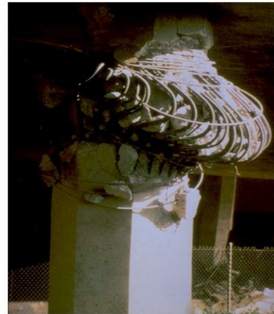
Figura 4 Colapso de una pila por proyecto inadecuado de la rótula plástica (autopista de Santa Mónica, terremoto de Northridge -17 de enero de 1994-. Fotografía de M. Celebi, US Geological Survey)
