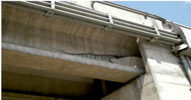
Figura 3 Fallo del alma de una viga por ausencia de diafragmas (terremoto de Concepción -27 de febrero de 2010-)
